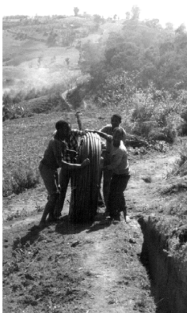
Vattenledningsrören kommer på plats. Foto: Jan-Olov Claesson.
